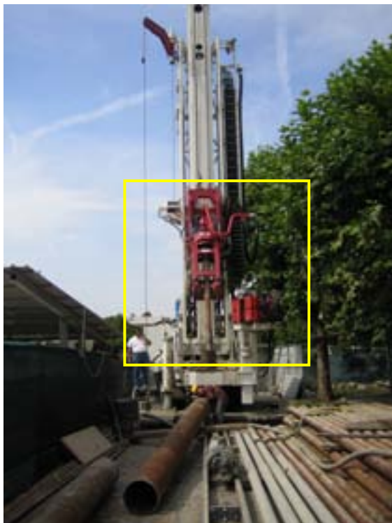
Fig 14 particolare di testa rotante su SOILMEC G55 Conc. Perforazioni Euganee s.r.l.(PD)
